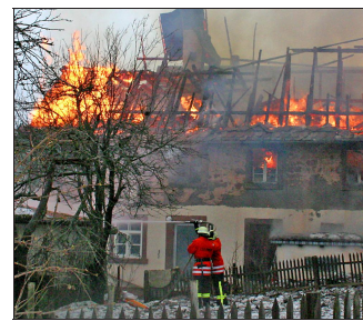
Ein technischer Defekt war wahrscheinlich Auslöser für den Brand. Foto: Dorer
